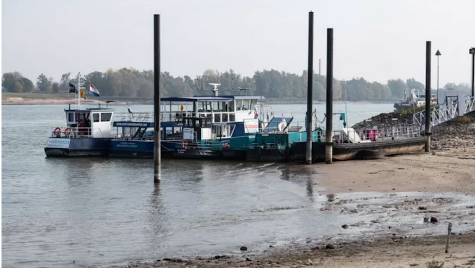
Laag water maakt aanleggen moeilijk
